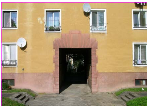
Foto č.3 – Průchod do ul.Stavbařské
